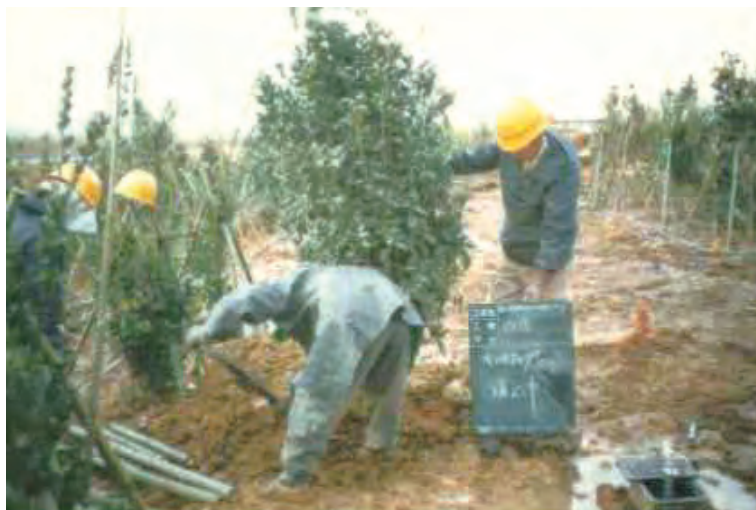
富山県空港スポーツ緑地工事風景写真 (B 地区)
